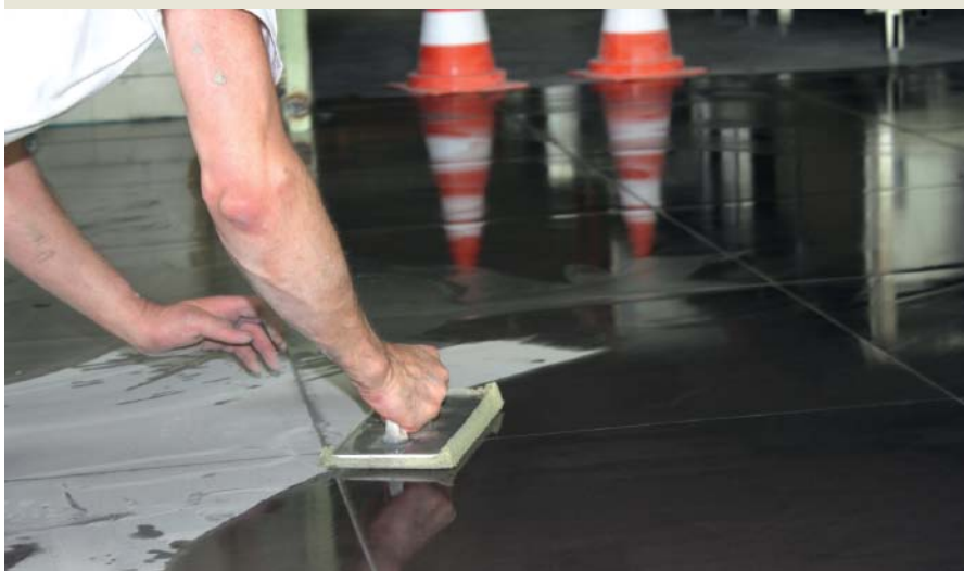
Verfugt wurde mit einem schnell erhärtenden Flex-Fugenmörtel.
