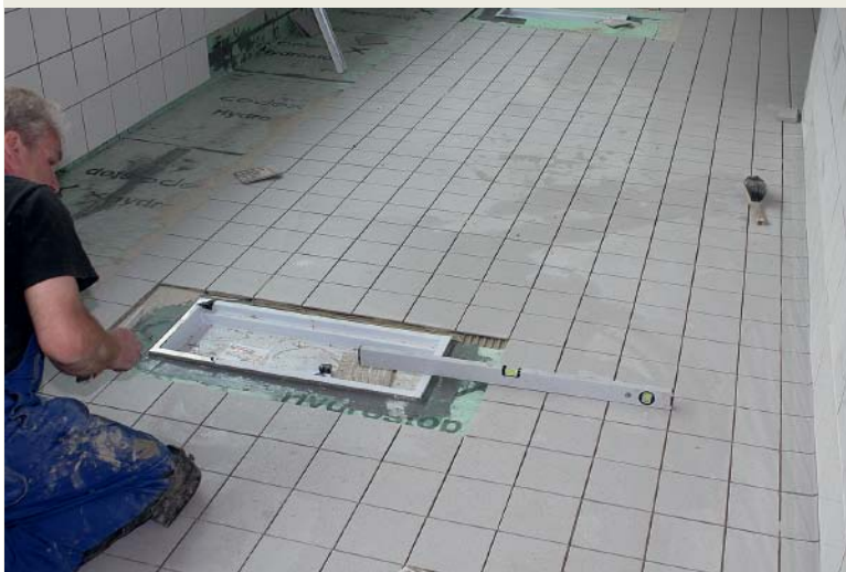
Für den sicheren Einbau der Abläufe, Rinnen und Ausgusswannen wurde ein epoxidharzgebundenes System gewählt.
