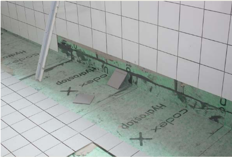
Die Nassbereiche wurden mit einer weich eingestellten Polyethylenbahn mit beidseitig aufgebrachtem Vliesgewebe abgedichtet.
